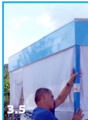
3.5 An Rückseite Dachstützen anbringen
